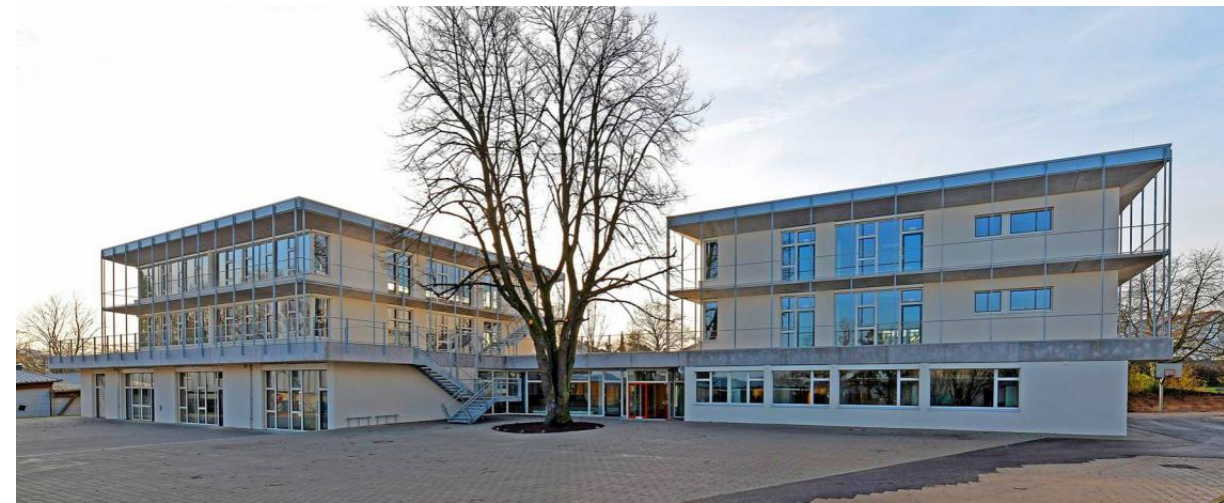
Der Gebäudekomplex der neuen Grundschule bietet allen Klassenstufen ein eigenes Stockwerk für ihre Räume. FOTO: STEFFEN SCHLÜTER
